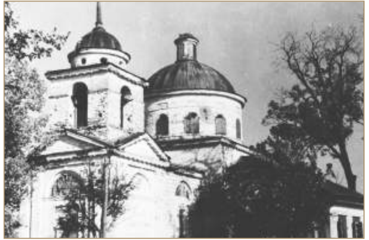
Kostel, stanoviště velitele obrany Sokolova nadporučíka Otakara Jaroše
