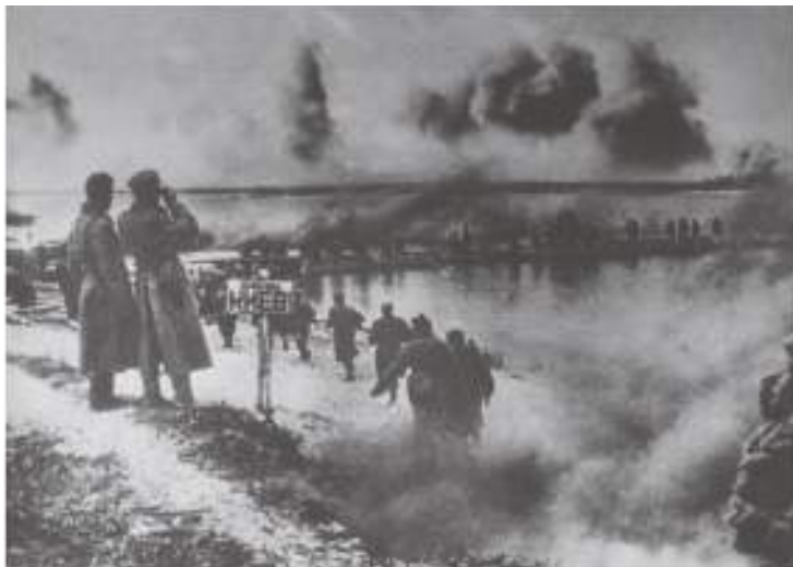
Přechod přes Dněpr
