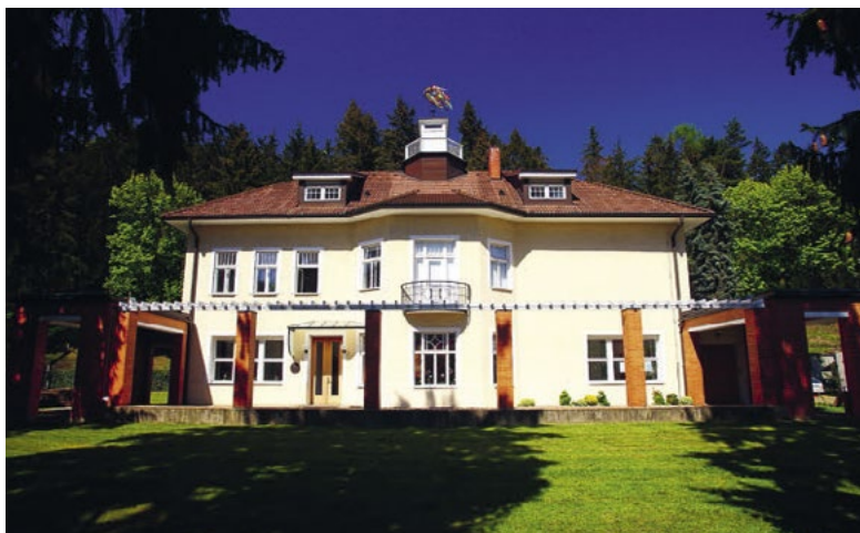
Pohled na jižní fasádu vily Tomáše Bati.
