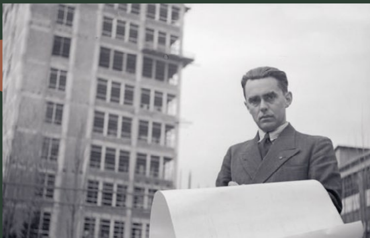
Architekt Vladimír Karfík dohlíží na výstavbu budovy 21.
