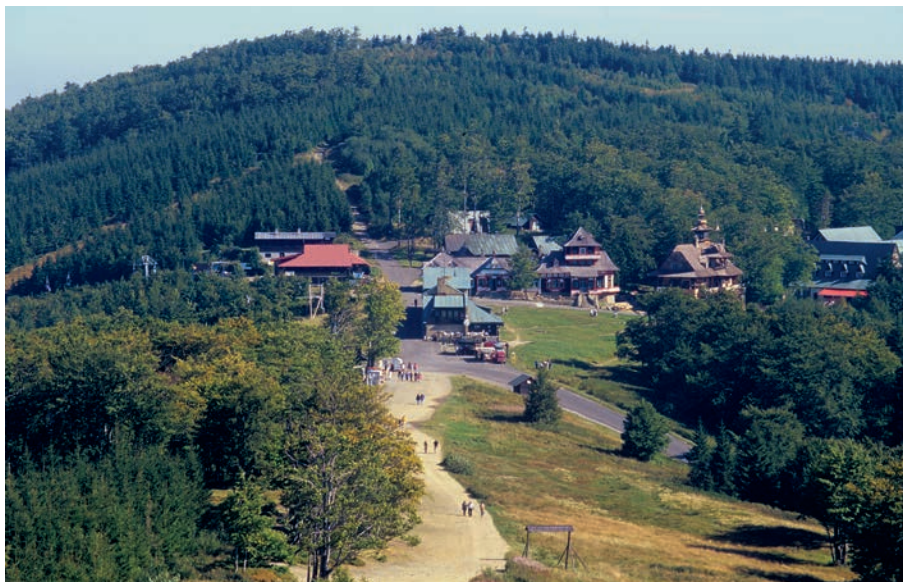
Sedlo Pustevny na hlavním hřebeni Moravskoslezských Beskyd. Památné Jurkovičovy stavby z roku 1898, s věžičkou Maměnka, sousední Libušín (před požárem v roce 2014)
