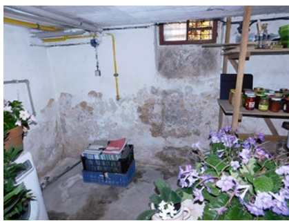
Obr. 2.7 a 2.8 Ukázka účinku velmi vysoké vlhkosti na omítku v suterénu
