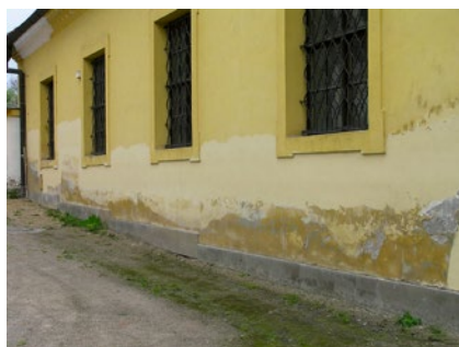
Obr. 2.11 a 2.12 Ukázka vztlínání vody z podloží a následného projevu na zdivo v 1. nadzemním podlaží v exteriéru
