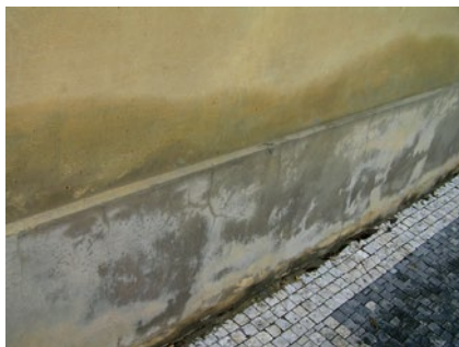
Obr. 2.11 a 2.12 Ukázka vztlínání vody z podloží a následného projevu na zdivo v 1. nadzemním podlaží v exteriéru
