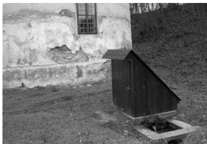
Obr. 2.1 Vysoká hladina podzemní vody a její negativní vliv na vlhkost zdiva u blízkého objektu
