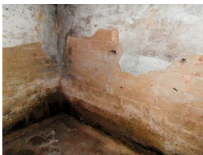
Obr. 2.7 a 2.8 Ukázka účinku velmi vysoké vlhkosti na omítku v suterénu
