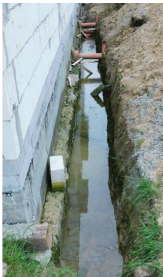
Obr. 2.3 Hladina podzemní vody v místě základů u obvodové zdi
