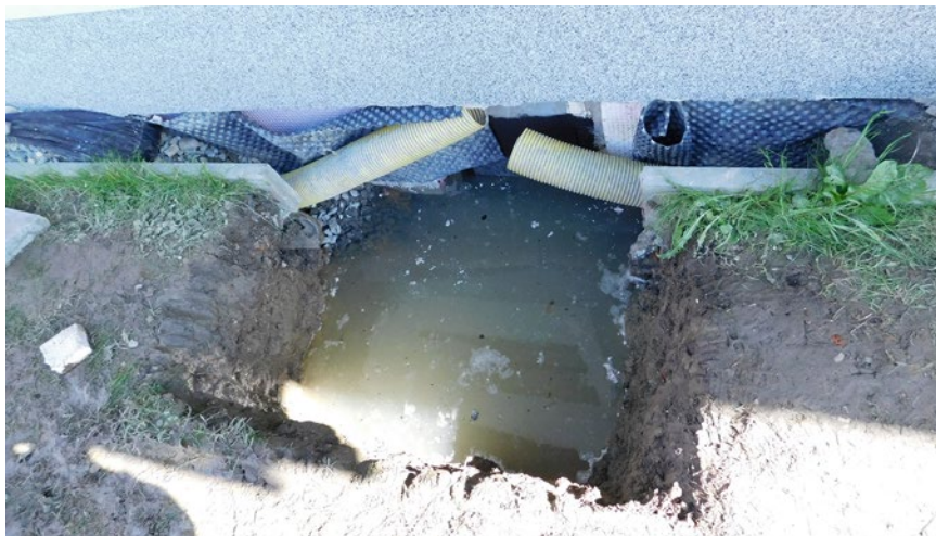
Obr. 2.5 Kopaná sonda u obvodového zdiva za účelem zjištění stavu hydroizolace
