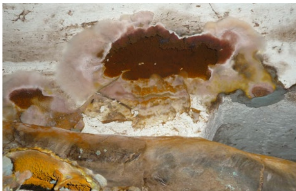
Obr. 2.6 Dřevomorka domácí
