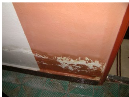
Obr. 2.9 a 2.10 Ukázka vztlínání vody z podloží a následného projevu na zdivo v 1. nadzemním podlaží v interiéru
