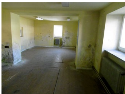
Obr. 2.9 a 2.10 Ukázka vztlínání vody z podloží a následného projevu na zdivo v 1. nadzemním podlaží v interiéru
